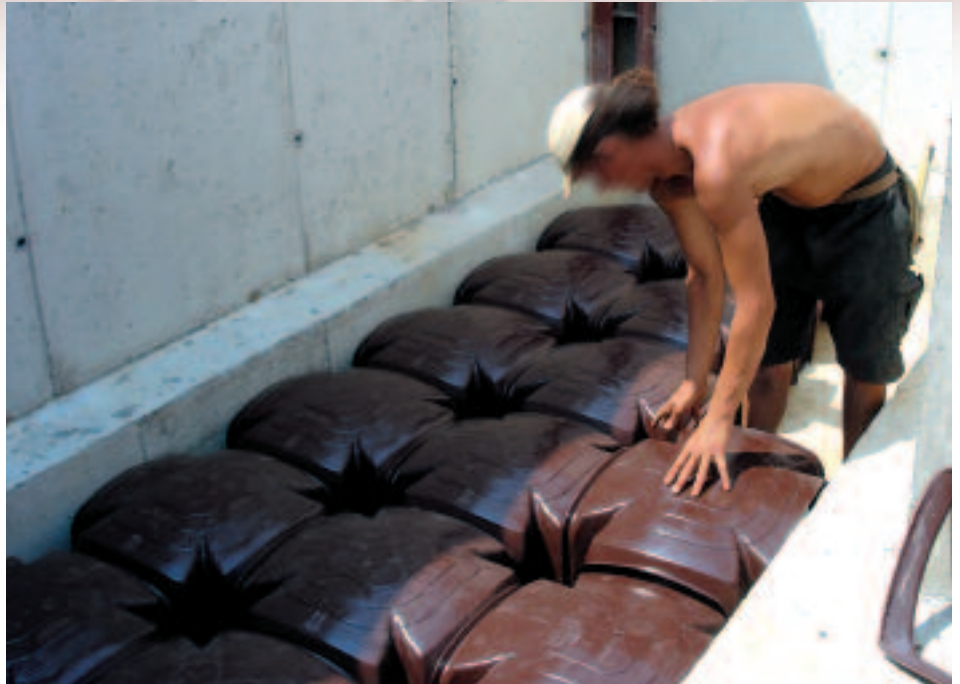
Foto 1 - Laying of Guttadrytek®
